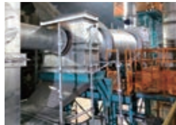
材料予熱装置の設置(水分・油分の除去)
